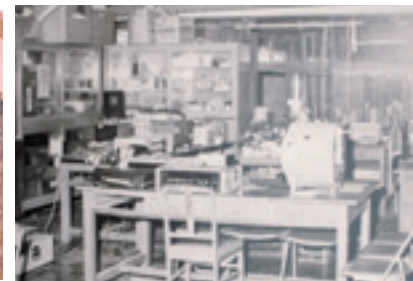
トレーニングセンター内部（1965年完成）
