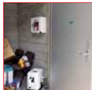
●ビーチバレーコート器具庫内
