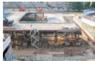
2007.8.21 仮設乗入構台完成
