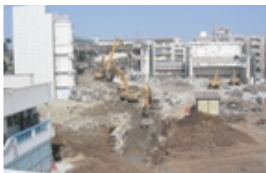
2007.3.29 3号館、4号館 解体
