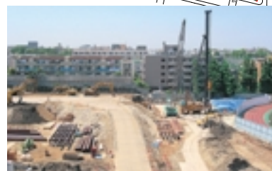
2007.5.21 山留工事開始 (中央斜路は重機移動用通路)
