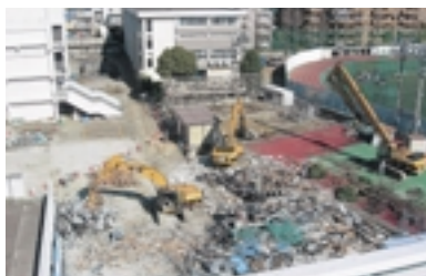
2007.3.8 観覧席、テニスコート、倉庫 解体
