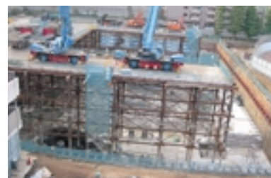
2007.10.11 仮設乗入構台施工中
