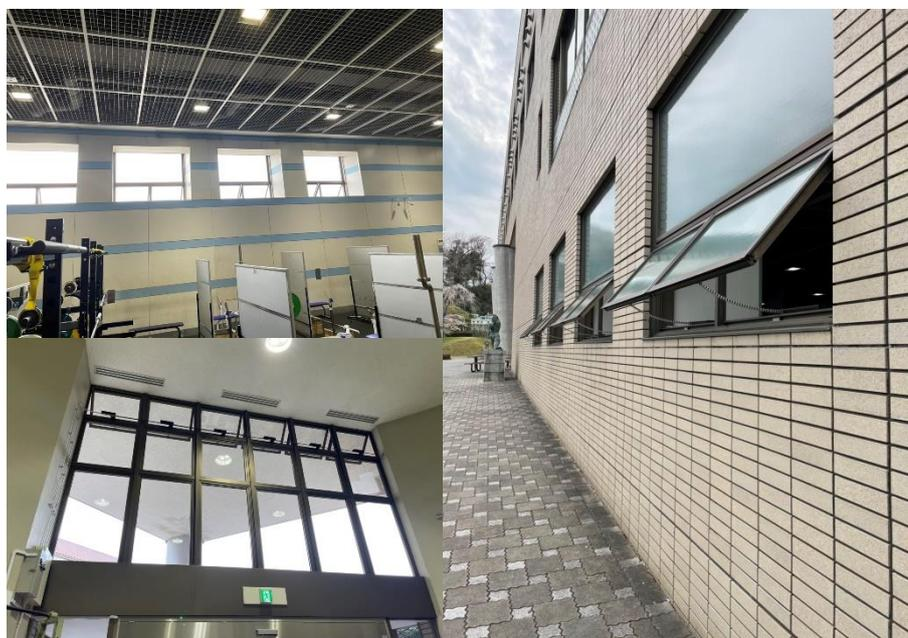
以前までは故障していたため使用していなかったが今後はどのように活用するのか検討中。今年度二酸化炭素濃度計を設置したため数値が一定数超えた場合に開放し空気の循環を行う。もしくは一定時間ごとに排煙窓を開け換気を行う。
